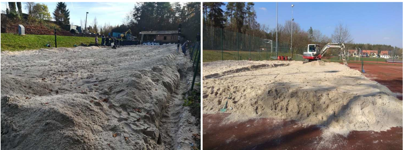
Abbau und Wiederaufbau der Beachvolleyballanlage
